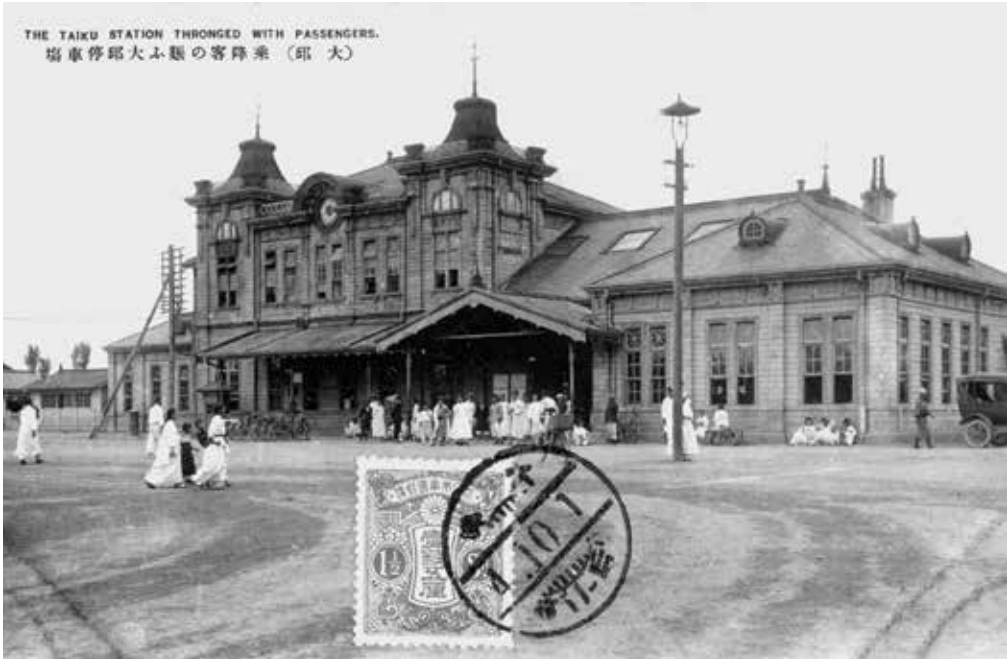
일제강점기 대구역 역사 전경
